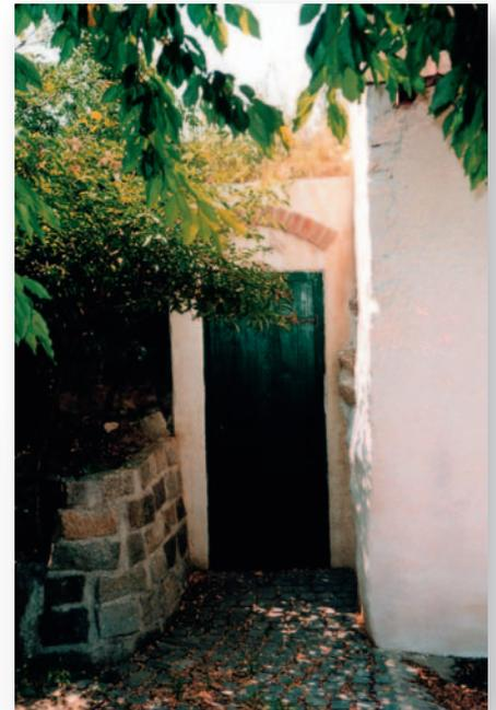
Verputzte Mauern mit einer Ziegelabdeckung sind in Kellergassen die Möglichkeit erster Wahl. Bei allen Stützmauern ist auf eine genügend tiefe Fundierung zu achten (Frosttiefe).
