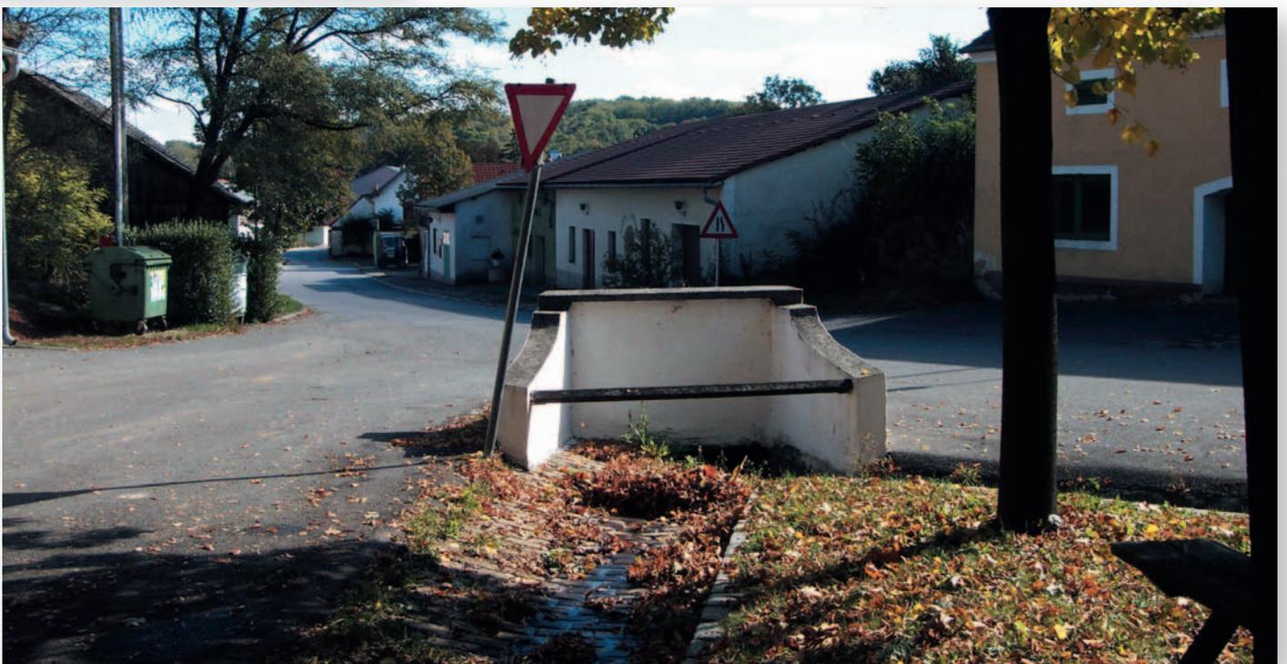
Ein gemauertes Einlaufbauwerk als Alternative zu optisch wenig ansprechenden, rein funktionellen Rohr- und Gitterkonstruktionen
